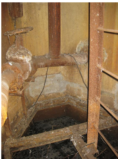
11.att. Esošie cauruļvadi un noslēgkrāni stipri korodējuši. Šahtu daļa applūdusi.
