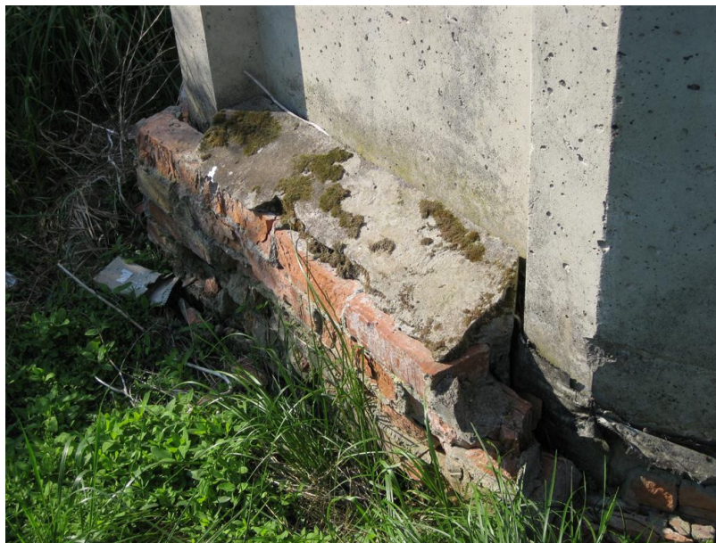
5.att. Cokola daļā izveidoti apmūrējumi, kas saplaisājuši un izdrupuši. Apmale ap ēku nav konstatēta.
